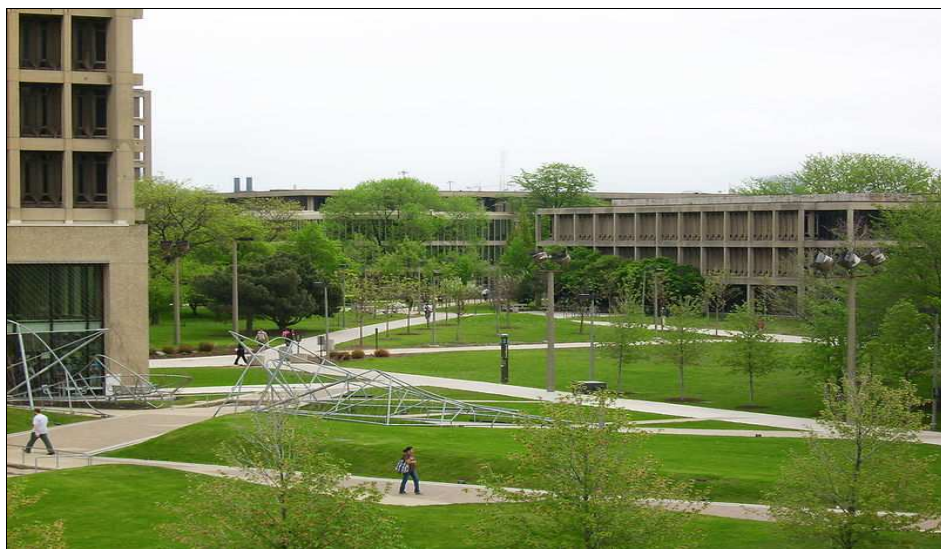
Figura 3 – Riferenze: Alcuni edifici ad uffici in un business park
